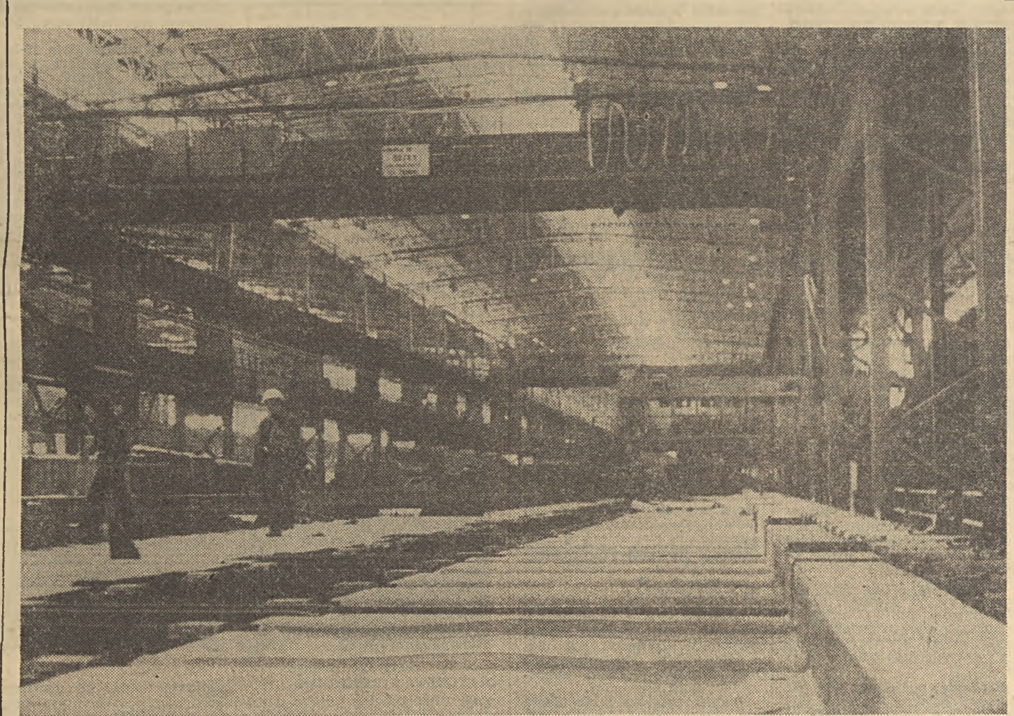
W walcowni dużej huty „Katowice”. Dobiega tu końca montaż klatek walcowniczych i samotoków. Walcownia będzie produkować szyny i duże kształtowniki. Docelowa produkcja — 1.200 tys. ton gotowych wyrobów hutniczych rocznie.
