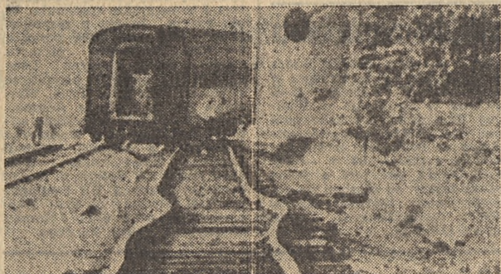
Upały roztopiły szyny. 24 br. roztopiły się na skutek straszliwych upałów szyny kolejowe w miejscowości Asbury Park w stanie New Jersey (USA), powodując wykolejenie się pociągu. (P)
