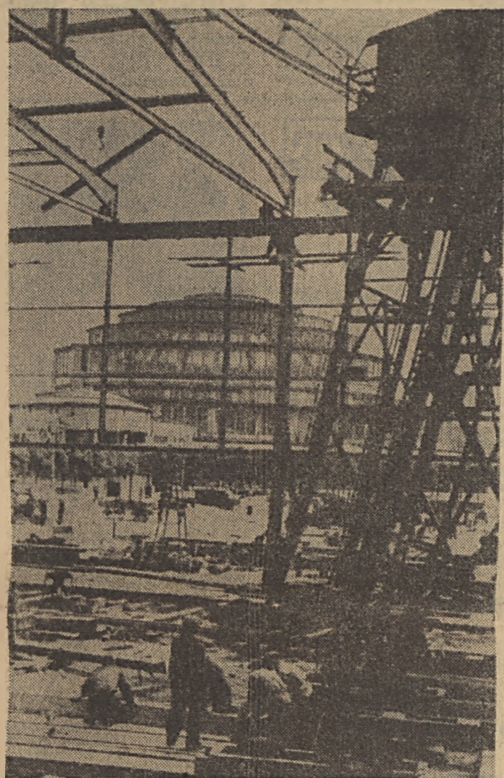
Montaż stalowych konstrukcji łuków i pawilonów wystawowych.
