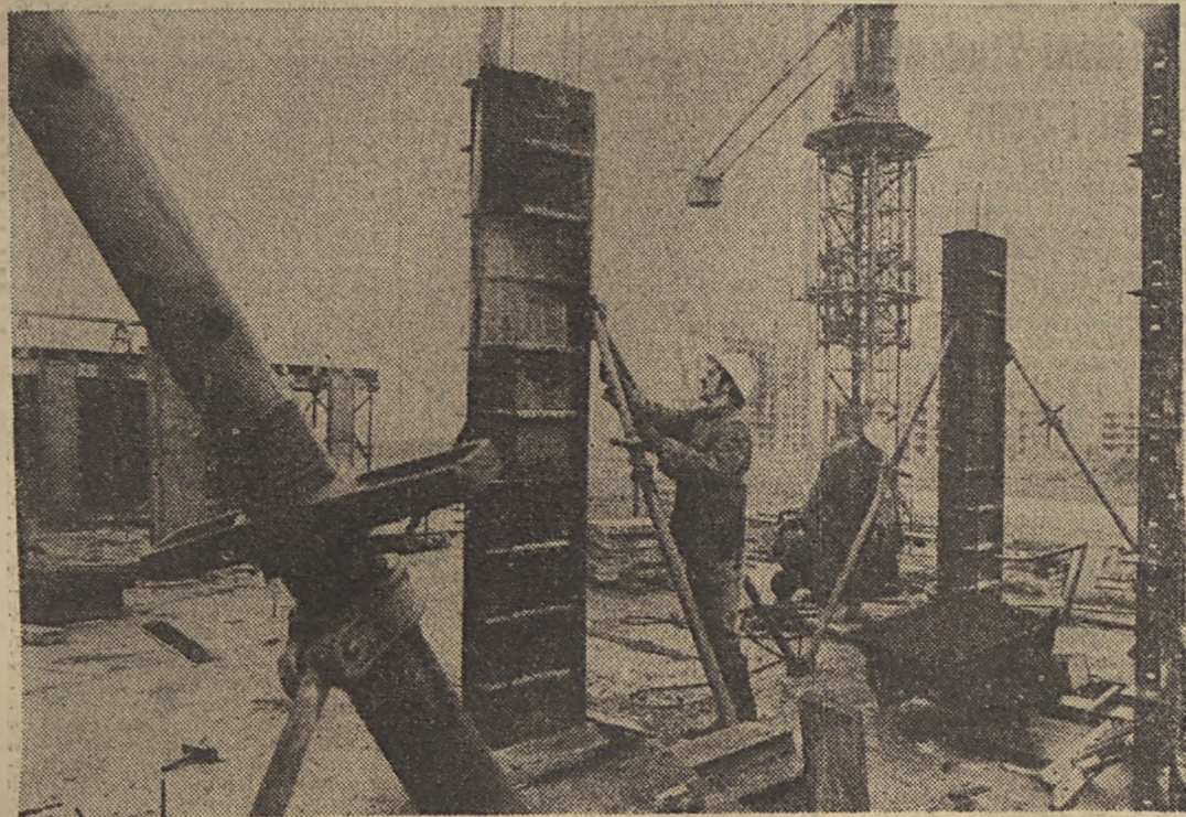
(P) Montowanie szalunków na drugiej kondygnacji hotelu dla pacjentów. Fot. Zdzisław Kwilecki
