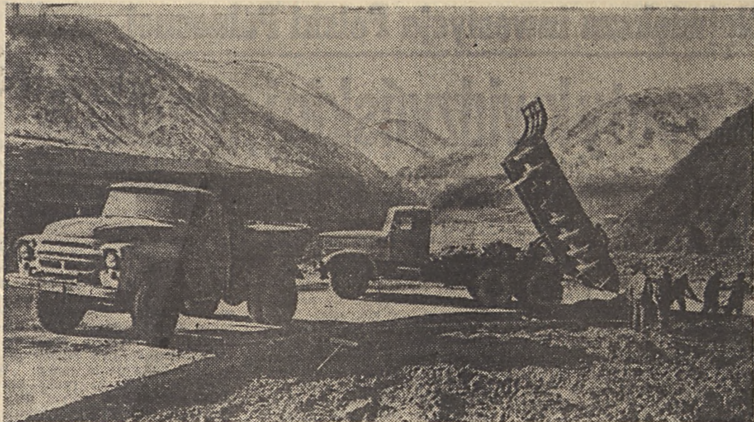
ZSRR — budowa Roguńskiej Hydroelektrowni. W górnym biegu rzeki Wachez, na wysokości 1100 m. n.p.m. trwa budowa Roguńskiej Hydroelektrowni, jednej z głównych inwestycji południowo-tadżyckiego kompleksu przemysłowo-terytorialnego, o docelowej mocy 3600 MW. CAF — TASS
