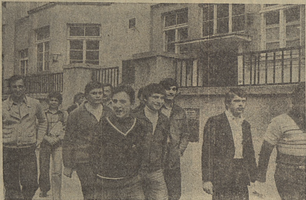
Uczniowie III klasy o specjalności mechanik kierowca pojazdów budowlanych już wkrótce pracować będą na stołecznych placach budowy
