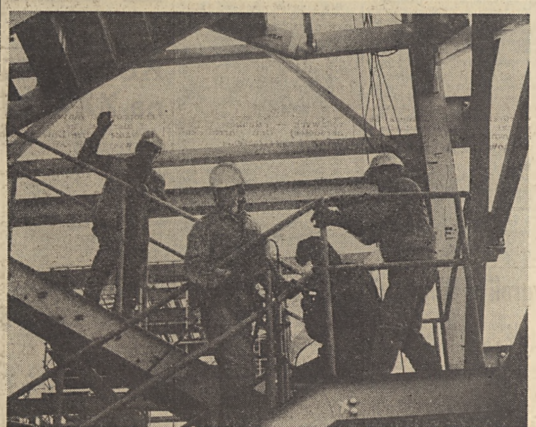
Budowa Zakładów Celulozowo-Papierniczych w Kwidzynie (woj. elbląskie) zalicza na jest do czołowych inwestycji przemysłowych w naszym kraju. Prowadzi się tu obecnie roboty na wielu odcinkach — na wszystkich obiektach montuje się konstrukcje. Najlepszym wykonawcą przy budowie celulozowni jest Gdyniński Przedsiębiorstwo Budownictwa Przemysłowego. Na zdjęciu: montaż konstrukcji hali pieca wapiennego.
