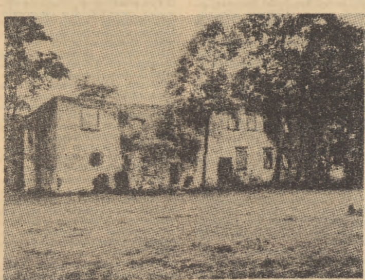
Ruina dworu w Skotnikach Koneckich
