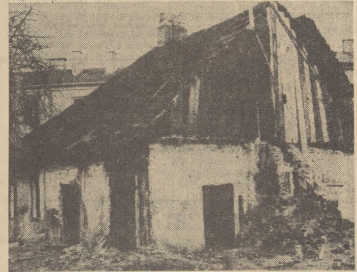
Rudera w sąsiedztwie restauracji „Frykas”. Od roku nie ma „silnych” na dokonanie prac rozbiórkowych.
