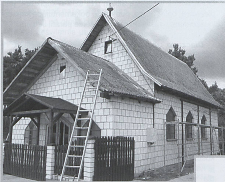
Kaplica przed remontem
