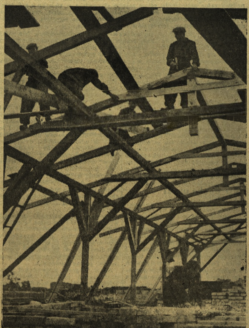
Za 52 dni 200 tys. młodych dziewcząt i chłopców — przodowników pracy z całego kraju — przyjadzie na Złot do stolicy. Warszawa już teraz przygotowuje się do przyjęcia młodych gości — budowniczych Polski Ludowej. W pięciu punktach stolicy trwają wyjątkowo prace przy budowie miasteczek złotych. Na zdjęciu: ochotnicy brzołowej złotowej budowy pomieszczenia gospodarcze na terenie miasteczka złotowego na Grochowie. Grupę młodych ochotników kieruje Tadeusz Jurko.
