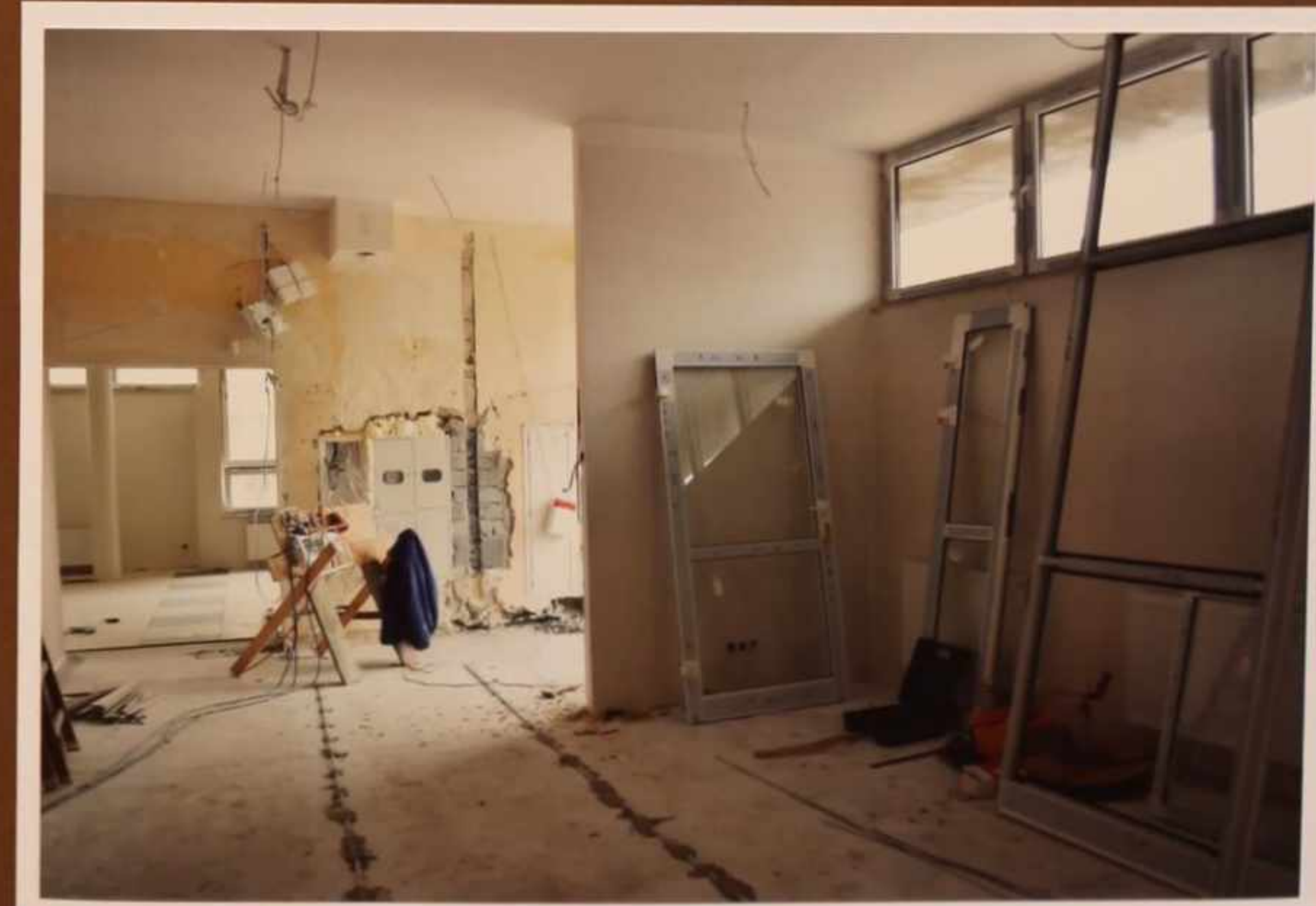
2011/2012 rok – remont filii
