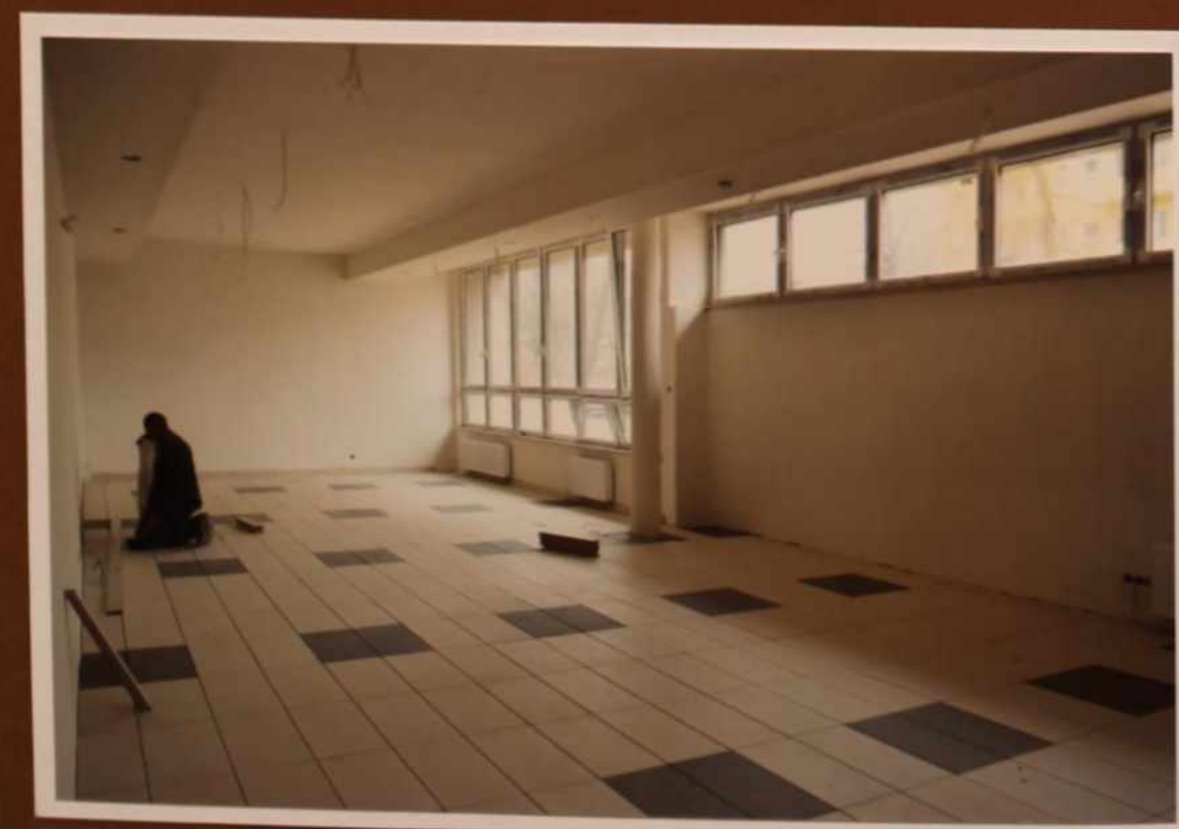
2011/2012 rok – remont filii
