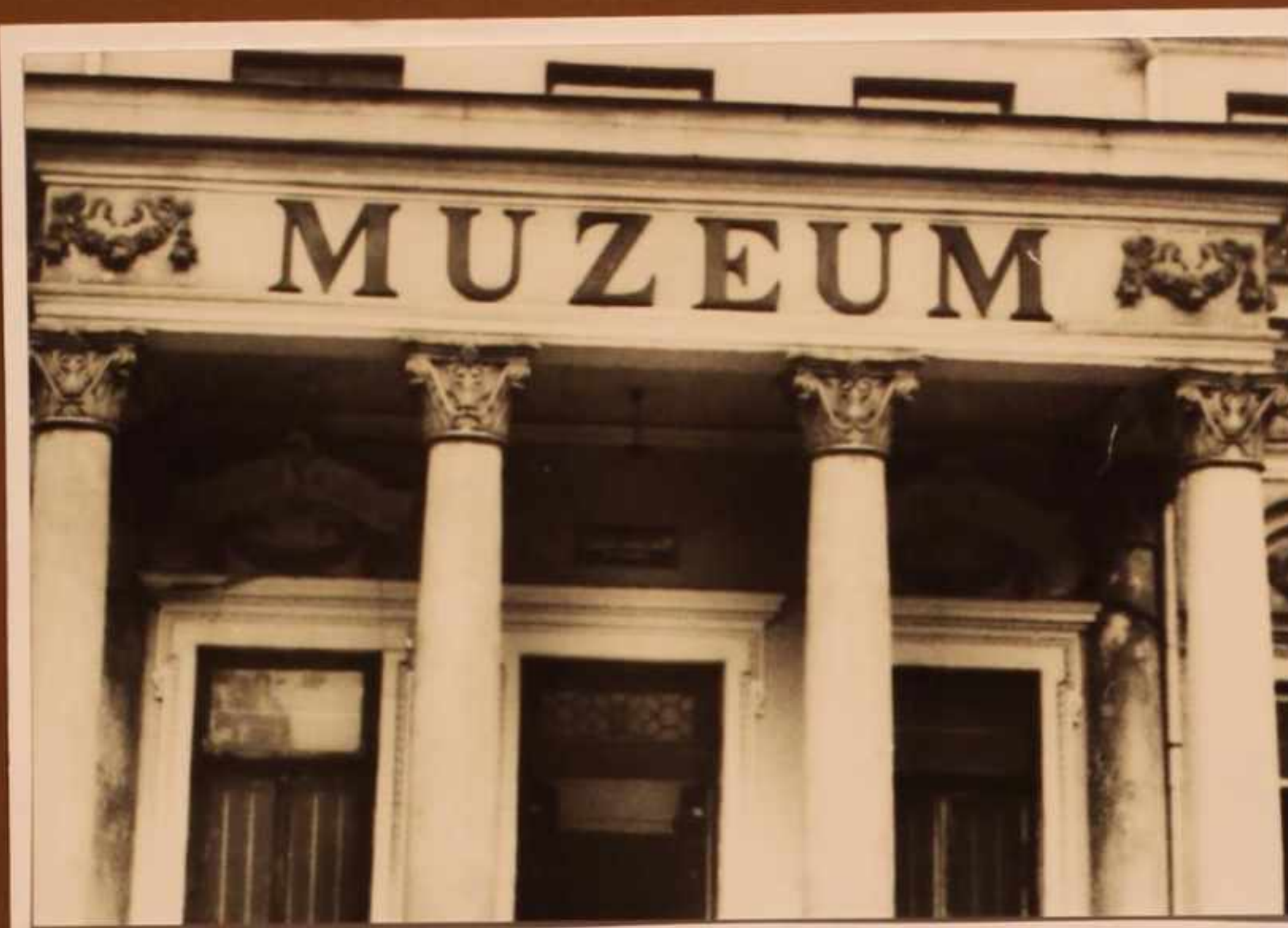
1992 rok – prace remontowe przy ul. Piłsudskiego 12
