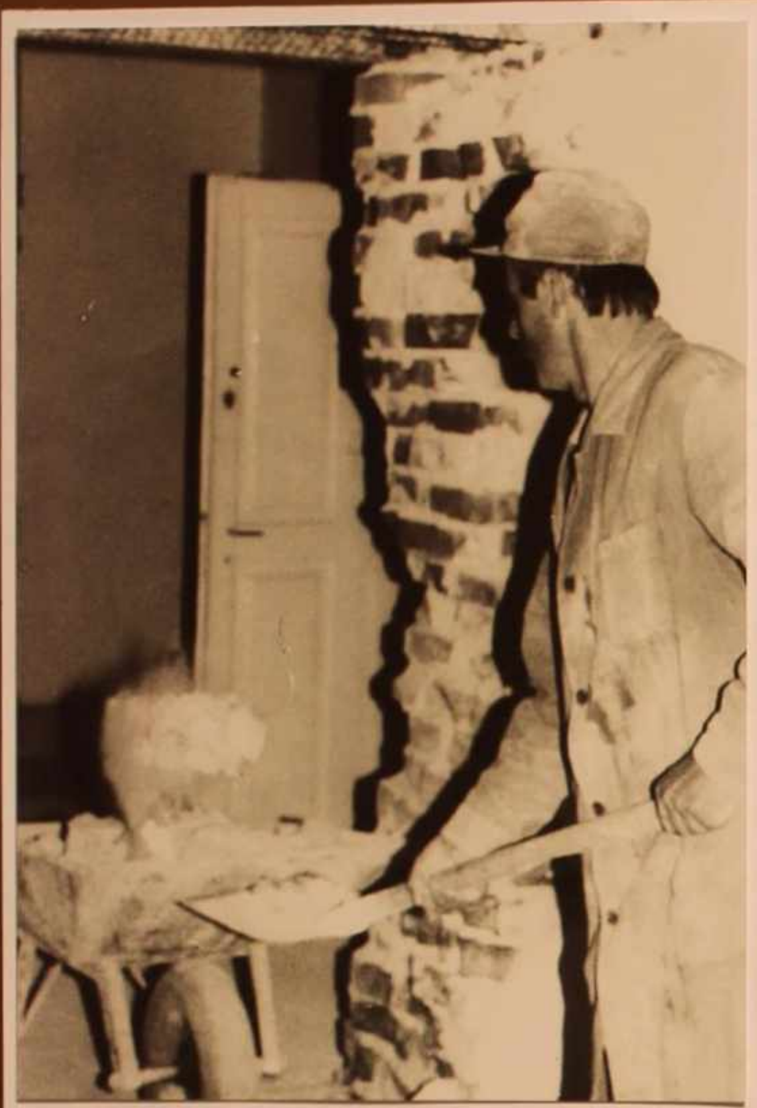
1992 rok – prace remontowe przy ul. Piłsudskiego 12
