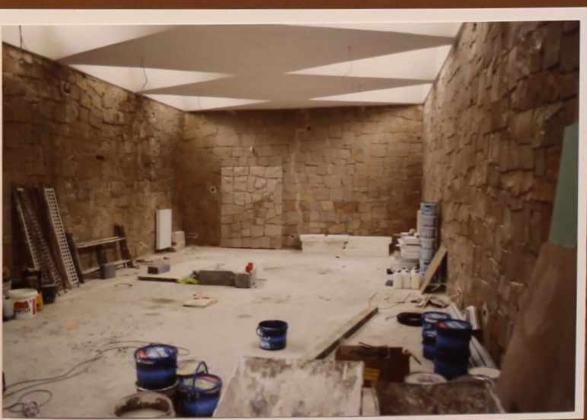
2011/2012 rok – remont filii
