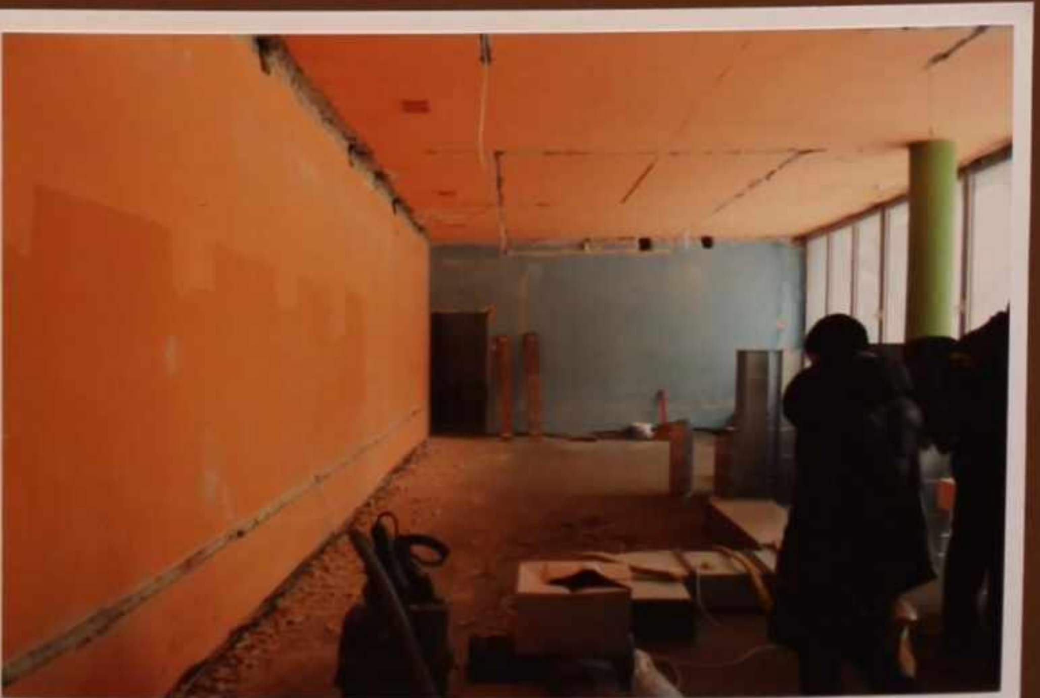
2011/2012 rok – remont filii
