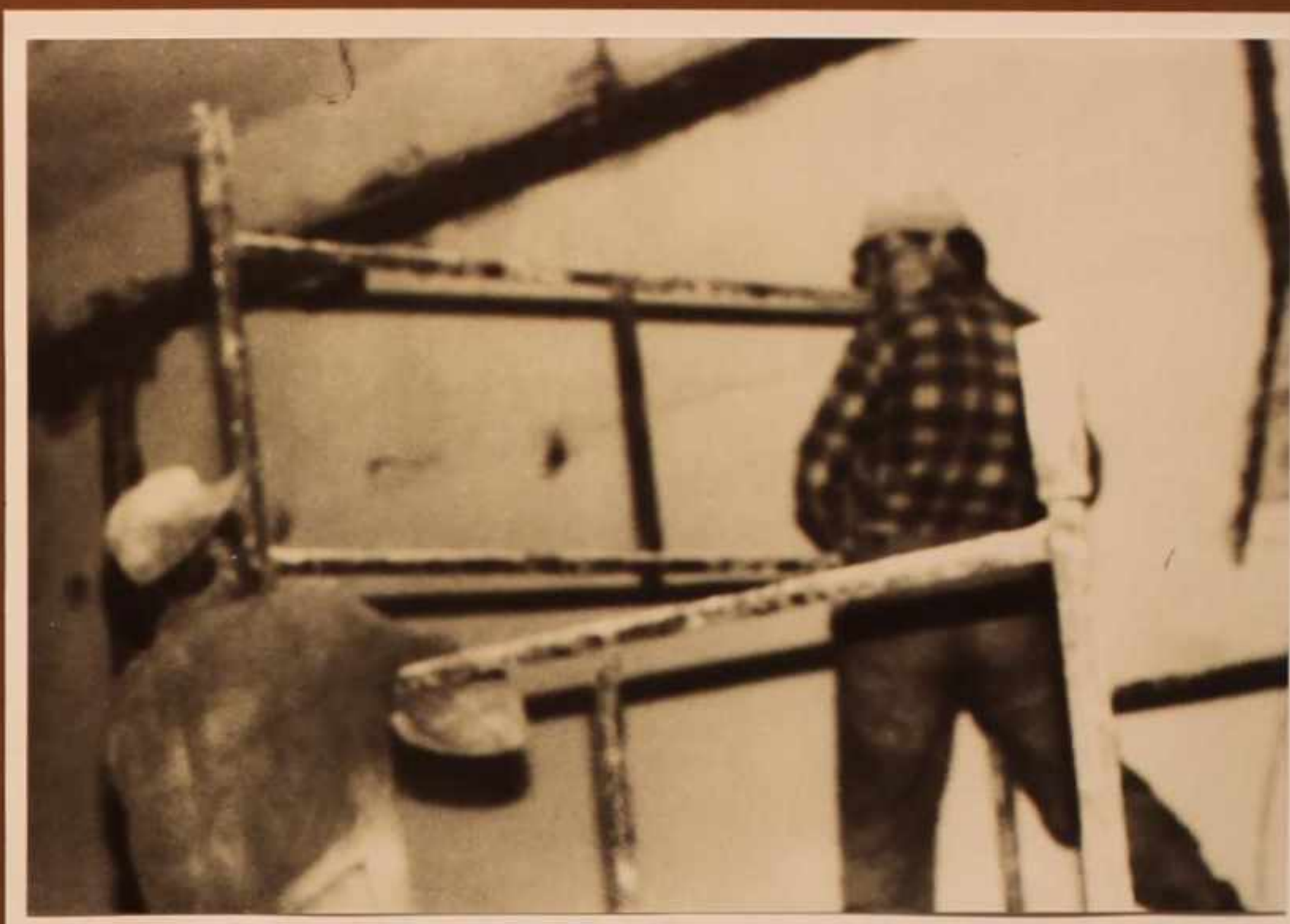
1992 rok – prace remontowe przy ul. Piłsudskiego 12
