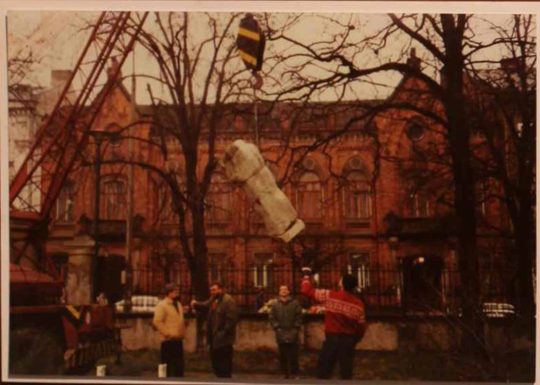
1992 rok – prace remontowe przy ul. Piłsudskiego 12
