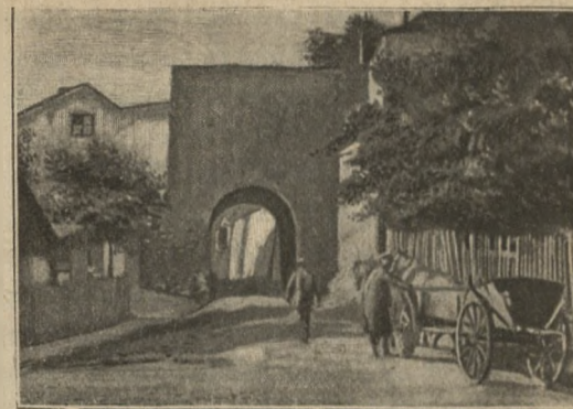
Brama wjazdowa w Opatowie.
