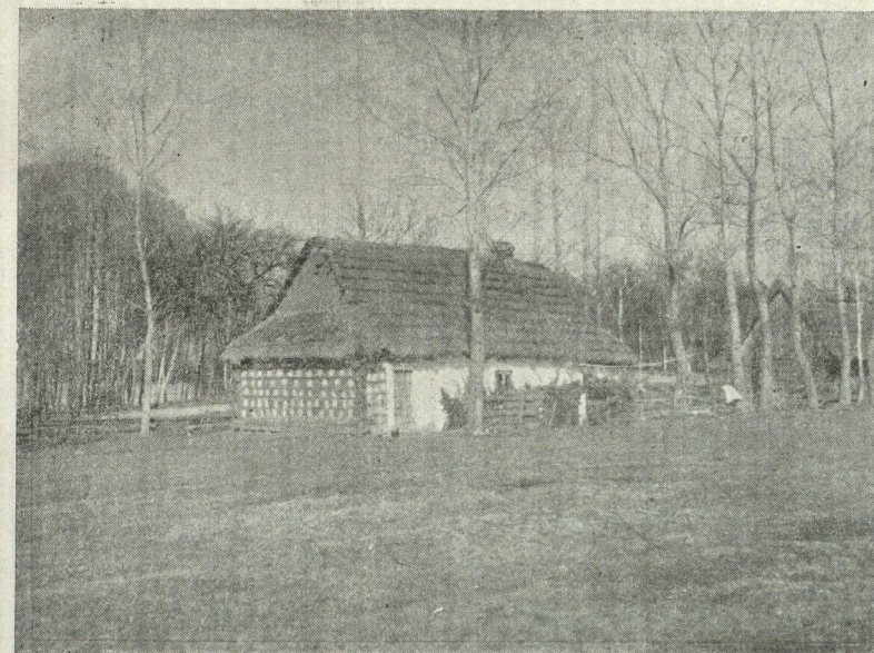
Dom zbudowany po r. 1864
