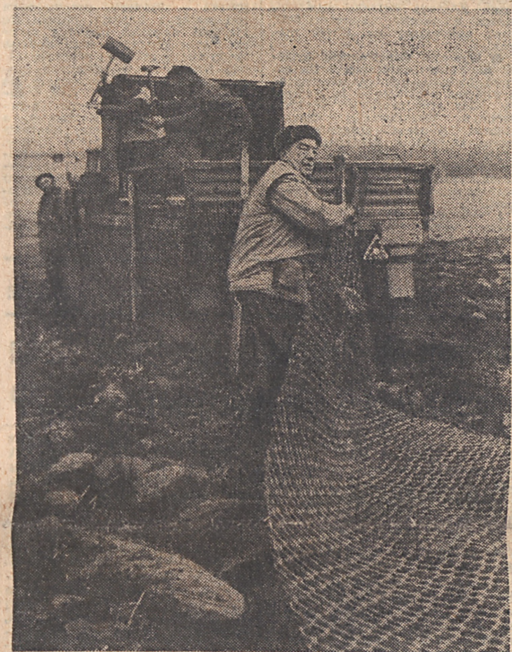
(P) Na głównych drogach województwa suwalskiego specjalne brygady Rejonu Drog Publicznych w Giżycku ustawiają plotki i rozciągają siatkę przeciwnieogową. Na zdjęciu: przy pracy brygady Kazimierza Duckiego i Jana Zdunka. Fot. CAF — Sienko
