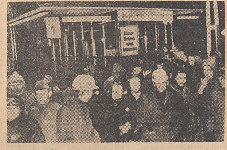
(P) Kryzys zachodnioeuropejskiego hutnictwa dotknął w ostat- nich latach również RFN. Oto jedno z ostatnich wydarzeń: 28 listopada 37 tys. robotników zachodniemiejskiego przemysłu metalurgicznego przystąpiło do strajku, żądając podwyżki płac i poprawy warunków pracy. Na zdjęciu: strajkujący robotnicy z zakładów w Duisburgu.
