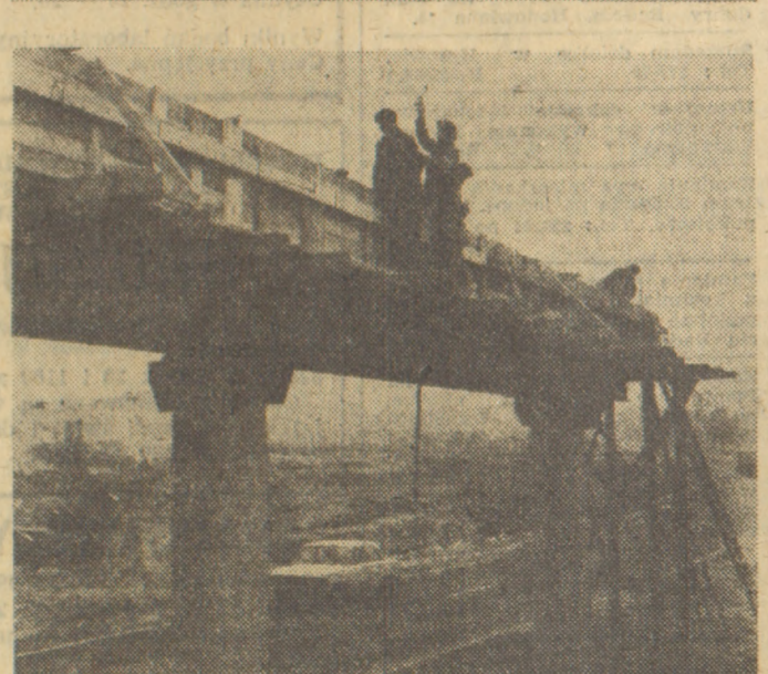
Modernizuje się kolejne odcinki międzynarodowej trasy E-7. W lipcu budownicowie
