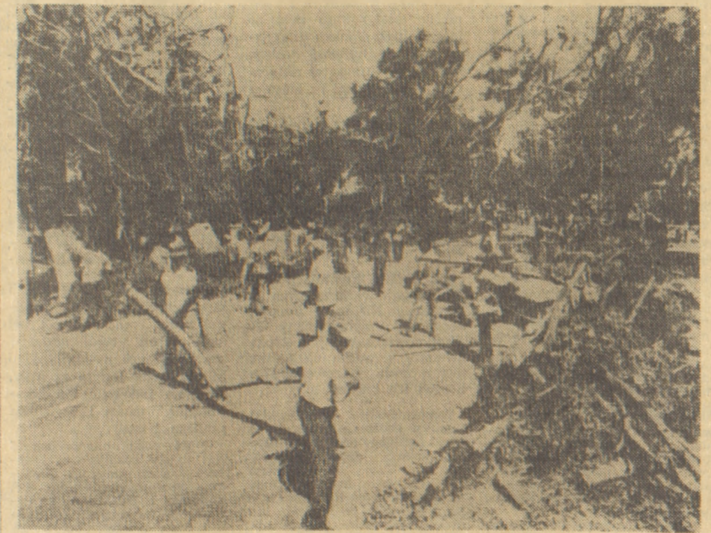
(P) Santo Domingo (Dominikana). Ulica w tym miejscu po przejściu „Davida” 31 sierpnia.
