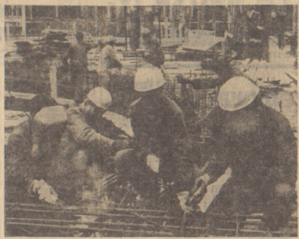
Na budowie w Żarnowcu. Trwają prace przy budowie elektrowni szczytowo-pompowej w Żarnowcu (woj. gdańskie). Na zdjęciu: siłownia główna — prace szalunkowe obudowy generatora nr 2. Przy pracy brygada zbrojarzy Alfreda Manyzki.
