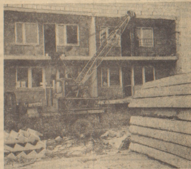
Montaż balkonów
