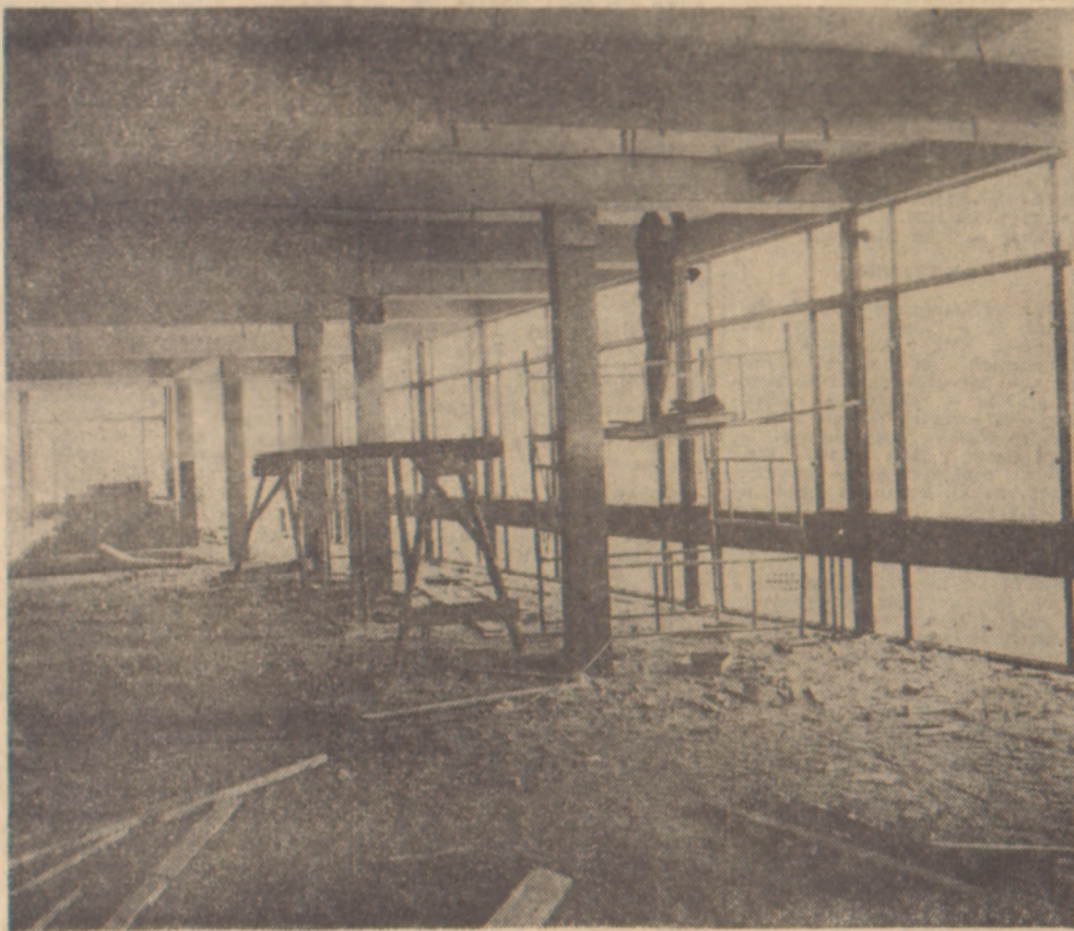
W stółówce trwają prace wykończeniowe
