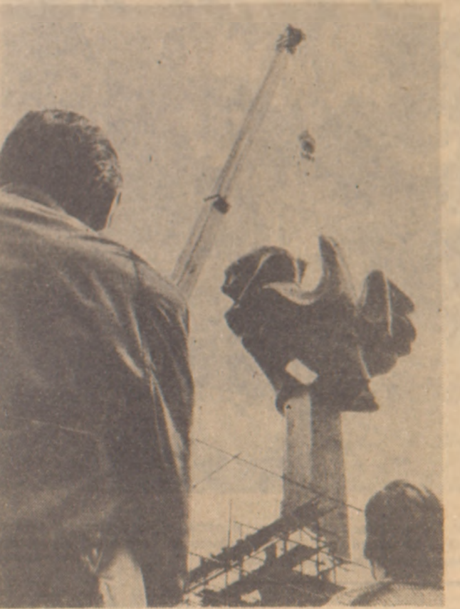
(P) W Szczecinie trwają prace przy budowie Pomnika Czynu Polaków. Na zdjęciu: osadzanie pierwszego orla na kolumnie. CAF—Udro—Telefoto
