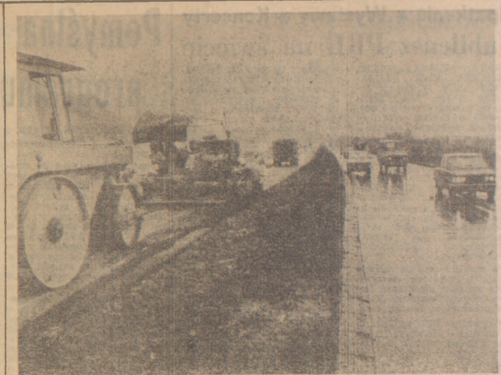
Szybciej i bezpieczniej. W celu usprawnienia ruchu turystycznego budowane jest przedłużenie trasy E-16 z Katowic do Wisły. Niedawno przekazano do eksploatacji jedno pismo drogi szybkiego ruchu z Nierodzim do Ustronia. Obecnie trwają prace przy budowie drugiego pasma. (P)
