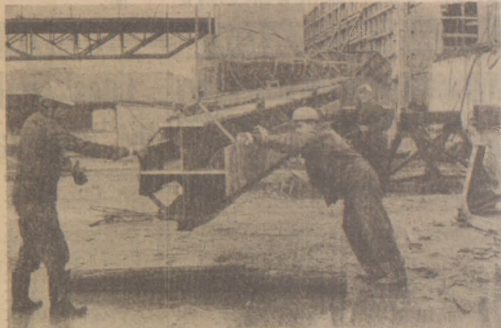
Na budowie elektrowni. W kolejną fazę wkroczyła budowa elektrowni „Opole”. Obecnie brzoza „Energomontażu-Zachód” wznoszą konstrukcję pierwszego bloku energetycznego. Na zdjęciu: brzoza Władysława Serafina podczas wznoszenia słupa nośnego kotła pierwszego bloku. Fot. CAF—Szwedzi
