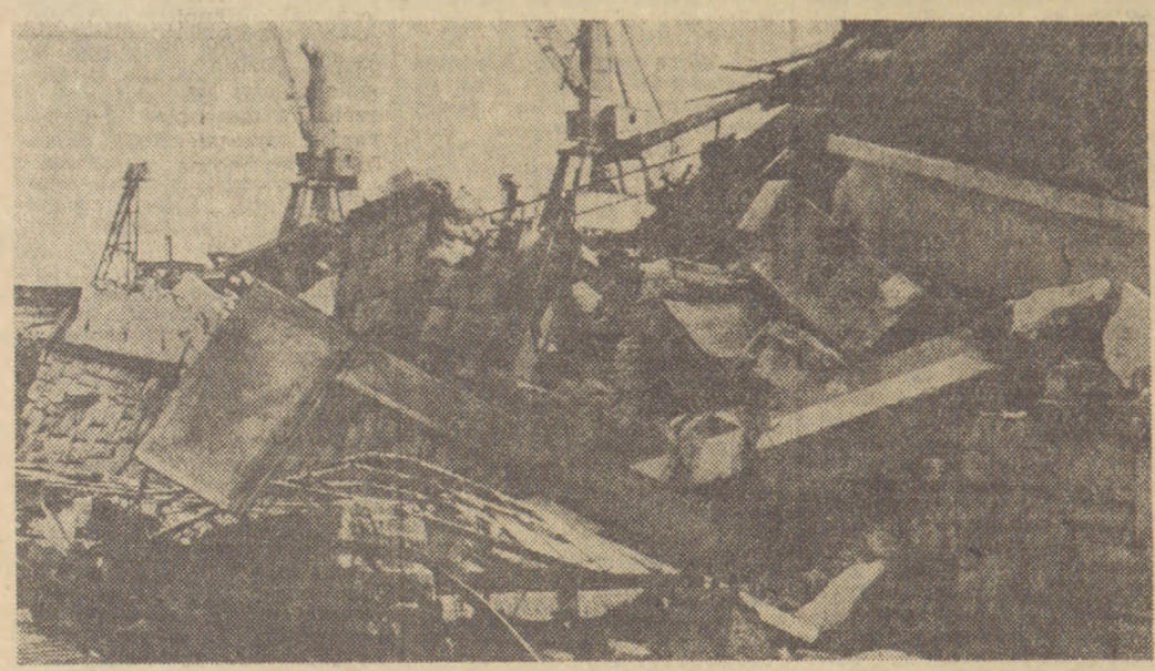
Zniszczenia w stoczni w Bijelu.
