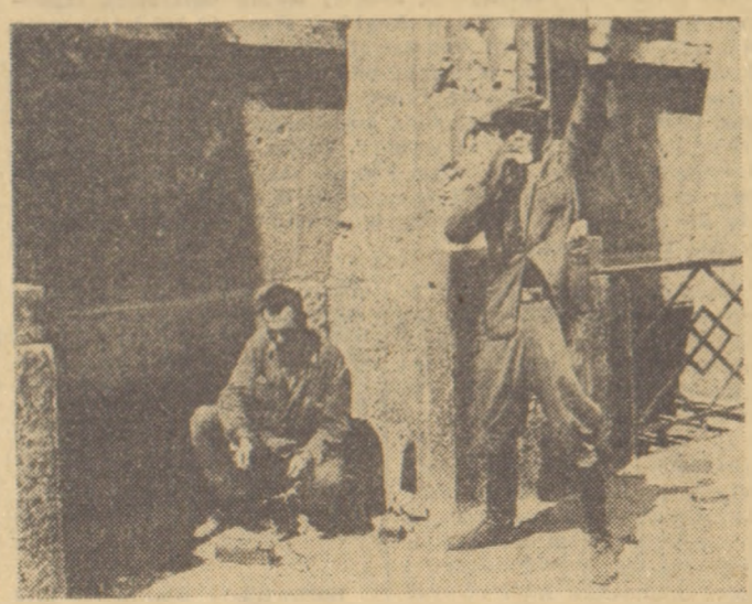
Wykopiowane zdjęcie z kroniki z 1945 r. Warszawscy saperzy wysadzają dom.
