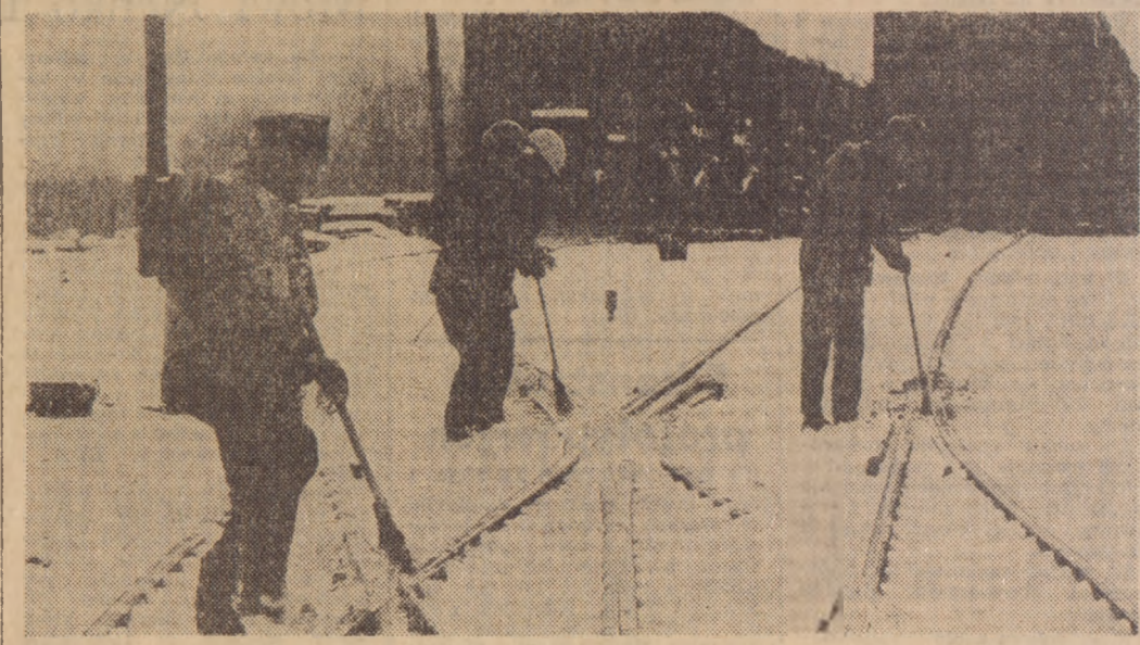
(P) Kolejarze odśnieżają rozjazdy na stacji Szczecin - Port Centralny.
