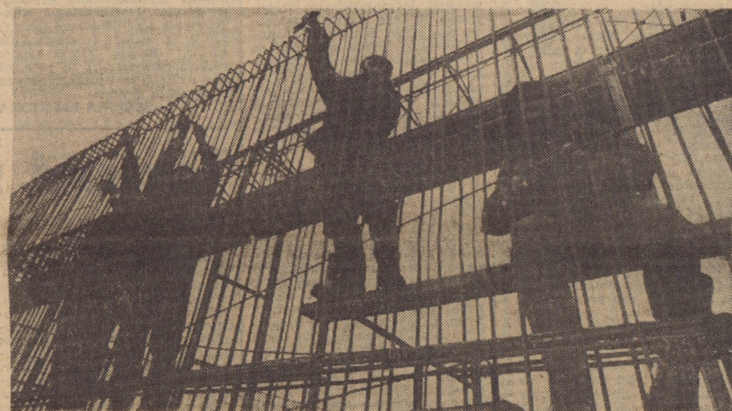
„Mgływ II” Inowrocławskie Zakłady Chemiczne (woj. bydgoskie) wkroczyły w okres rozruchu instalacji wytwórni sody ciężkiej. Soda jest jednym ze składników przy produkcji szkła. Na zdjęciu: zbrojarze z Bydgoskiego Przedsiębiorstwa Budownictwa Przemysłowego przy montażu magazynu wapienia.
