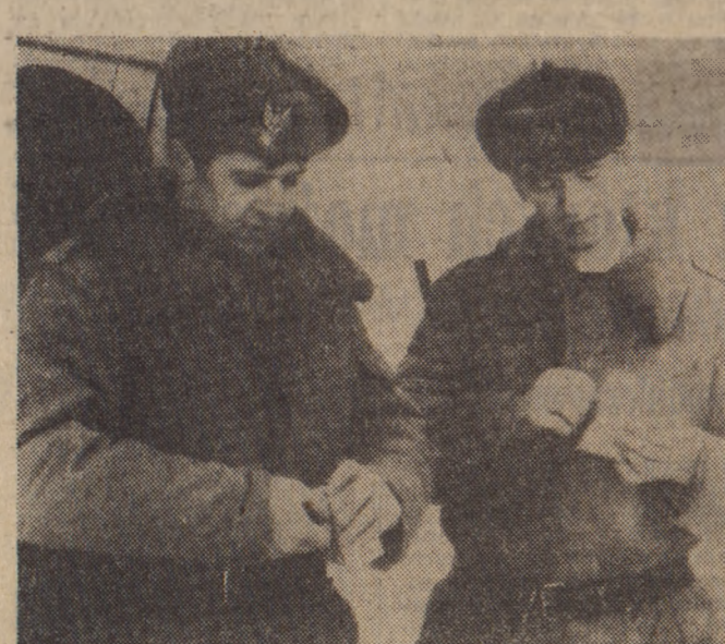
Saperzy w akcji. Na Odrze koło Katowic saperzy rozpoczęli kruszenie lodu materiałami wybuchowymi, by uchronić przed zniszczeniem istniejący tu jaz. (P) CAF — Hawalej
