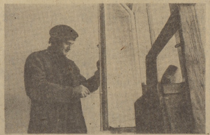
Stolarz Jan Brudziński poprawia osadzenie okna. Fot. Zbigniew Furman
