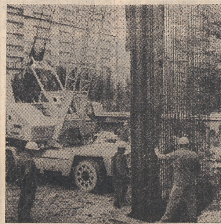
(P) Fundamenty pod oczyszczalnię ścieków dla Mennicy. Fot. Zdzisław Kwieciński
