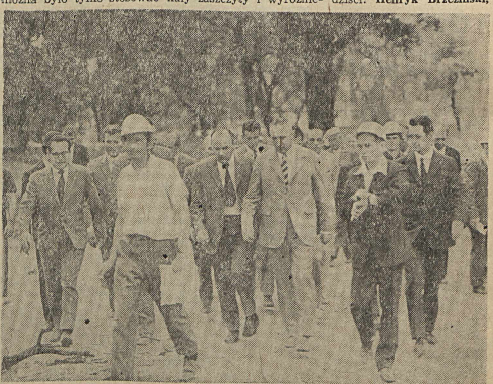
I Sekretarz KC PZPR — Edward Gierk wśród budowniczych Trasy Mostowej Łazienkowskiej.
