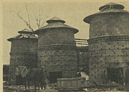
Ryc. 15. Staporków — prażaki do rudy żelaznej. — Photo-Plat, fot. Plater-Zyberk
