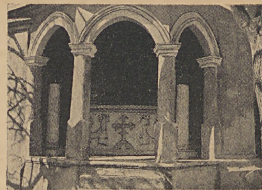
Ryc. 67. Tylna fasada kościoła parafialnego w Stopnicy. Fot. autor
