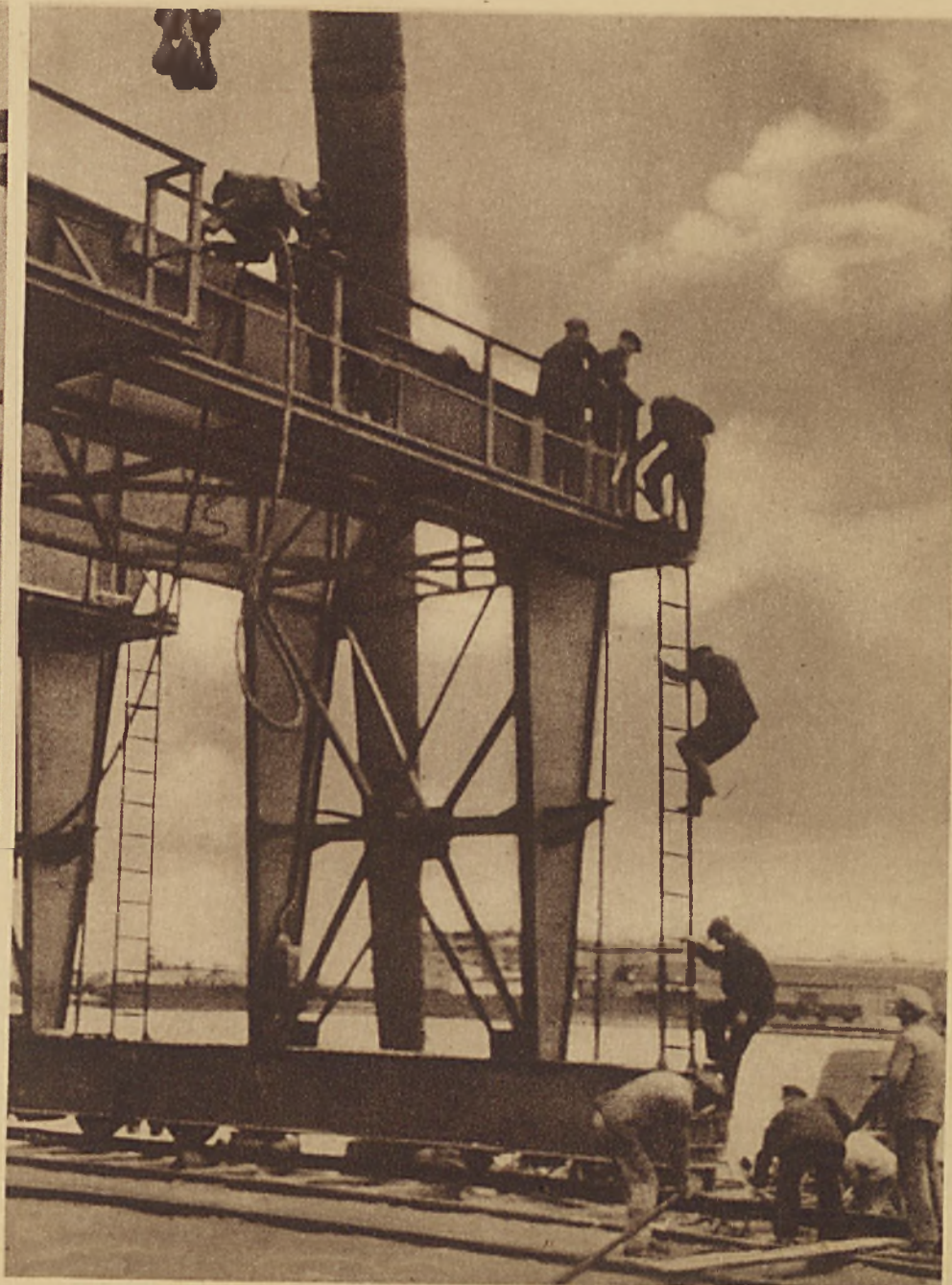
MONTOWANIE DZWIGU.
