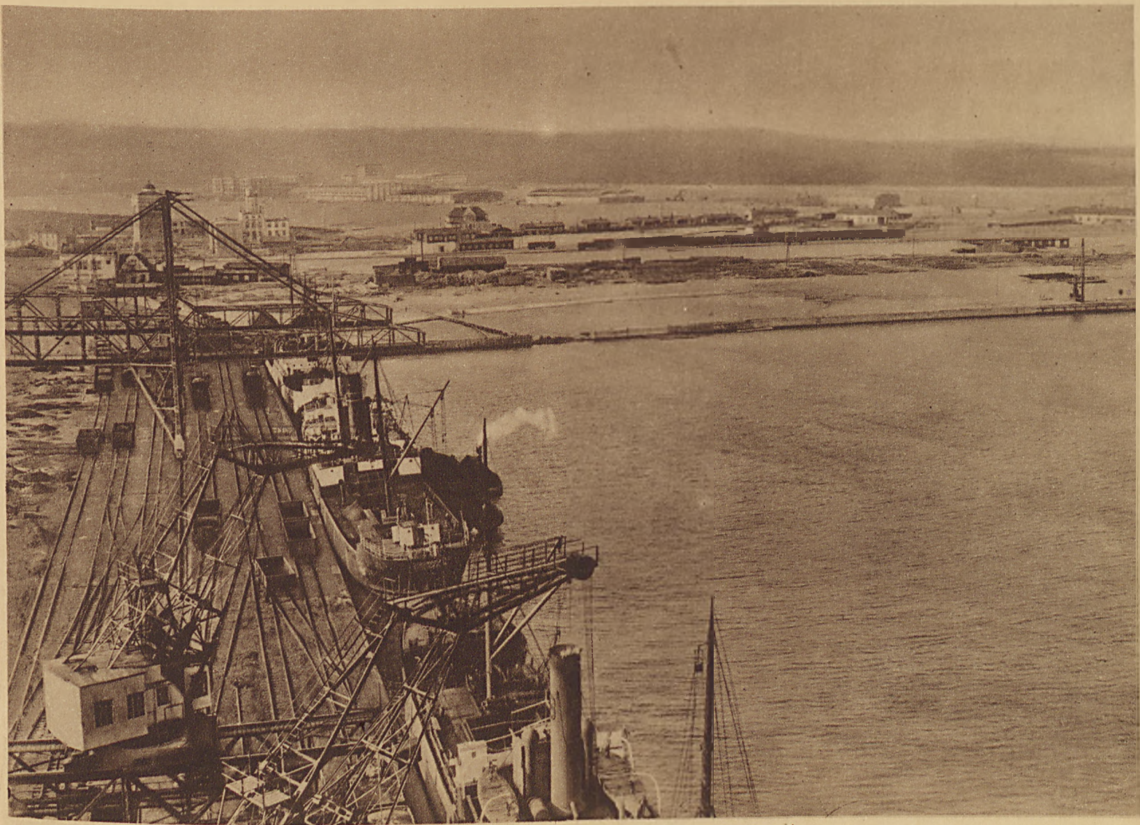
WIDOK NA PORT Z MOŁA WĘGLOWEGO.
