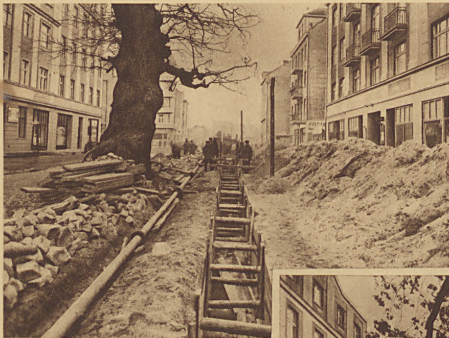
ZAKŁADANIE KANALIZACJI NA UL. PORTOWEJ.
