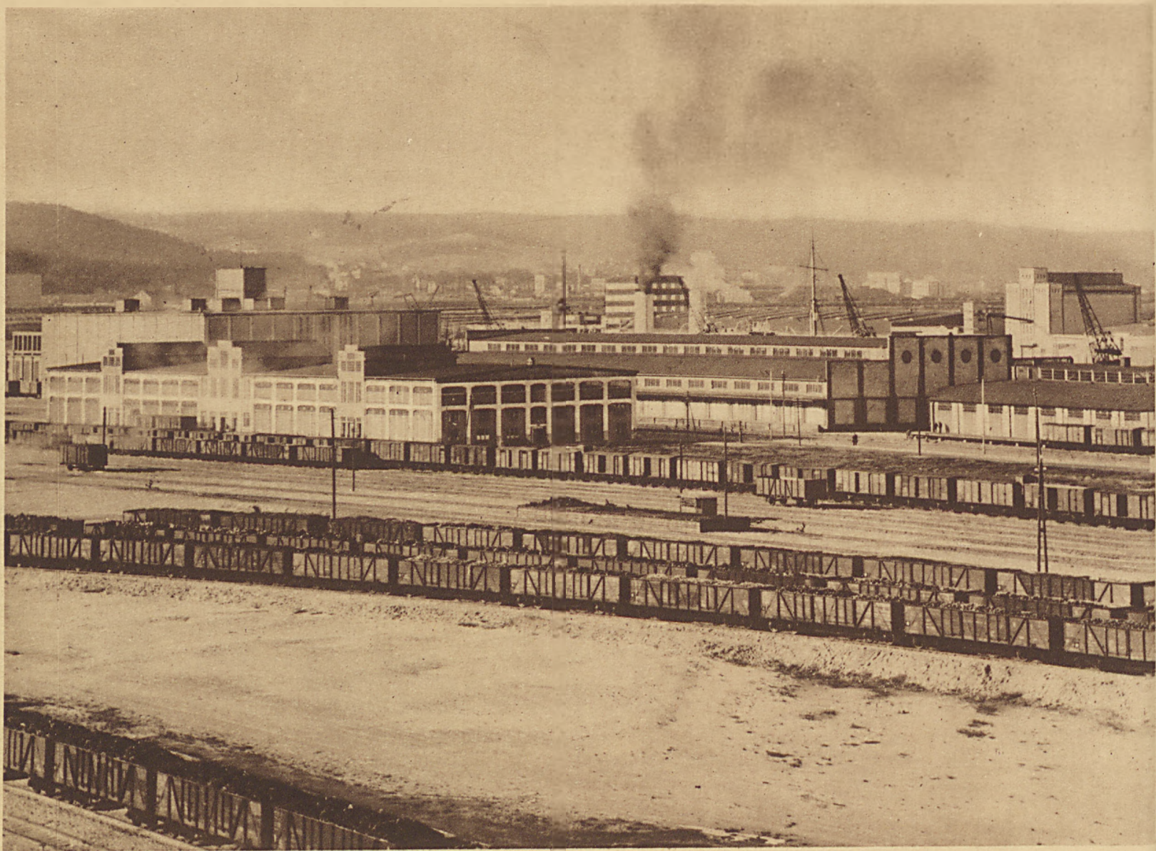
OGÓLNY WIDOK MAGAZYNÓW PORTOWYCH.
