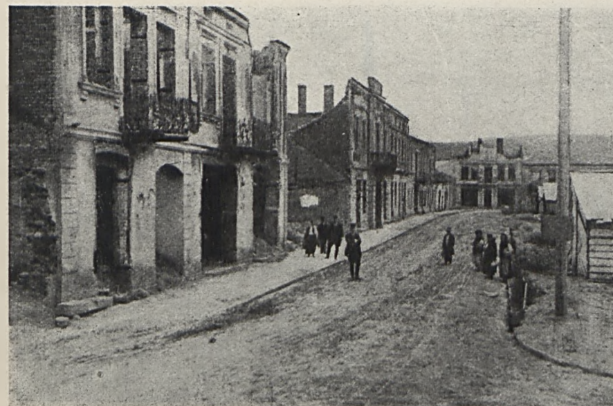
ZNISZCZONE DOMY PRZY ULICY BELWEDERSKIEJ W STANISŁAWOWIE MAISONS RUINÉES DE LA RUE BELWEDERSKA À STANISŁAWÓW
