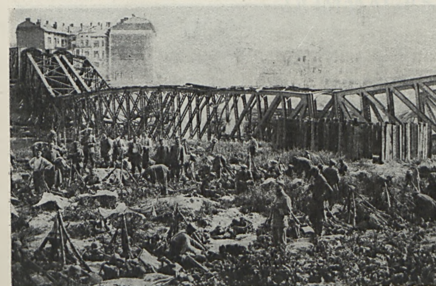
ZNISZCZONE MOSTY (W PRZEMYSŁU) PONTS DÉTRUITS (À PRZEMYSŁ)
