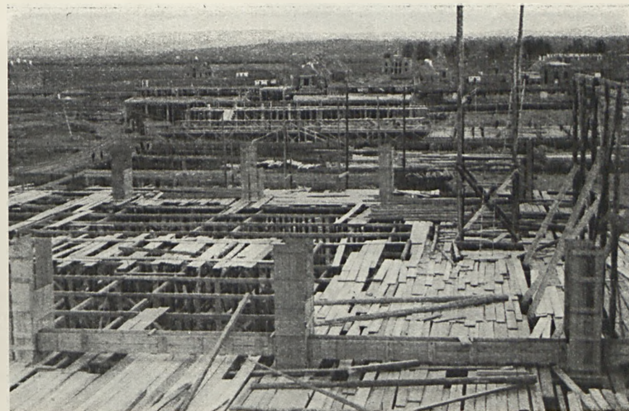
BUDOWA FABRYKI ZWIĄZKÓW AZOTOWYCH W TARNOWIE CONSTRUCTION DE L'USINE DES PRODUITS AZOTÉS À TARNÓW
