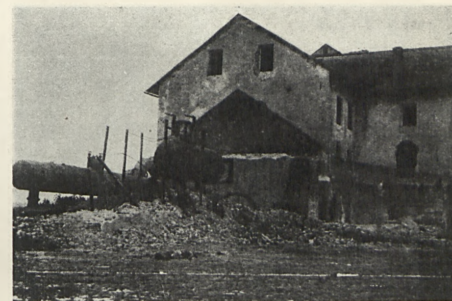
ZBURZONA GORZELNIA RAFFINERIE D'ALCOOL DÉMOLIE
