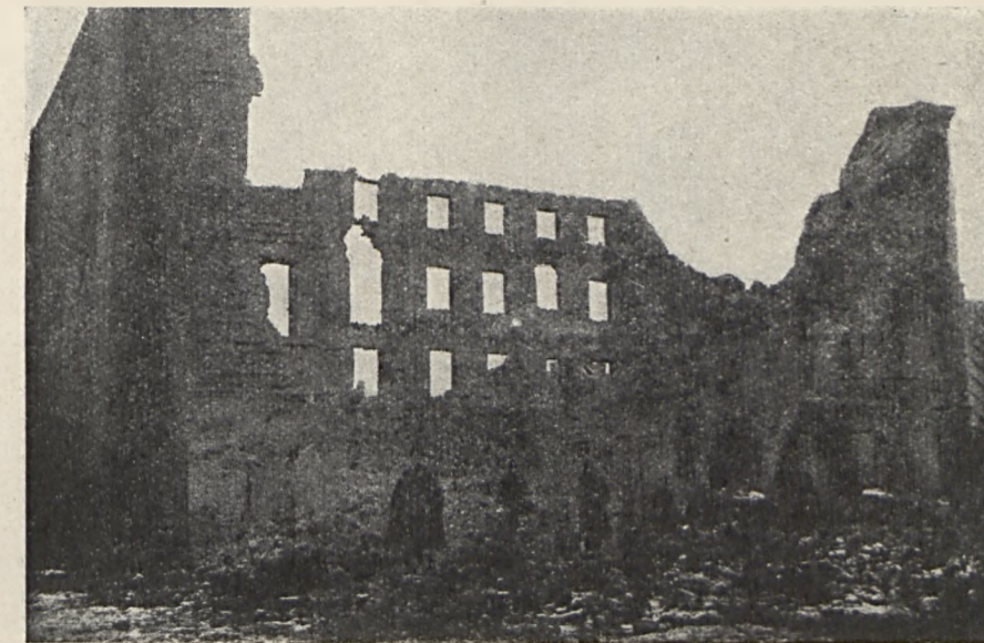
ZBURZONE DOMY NA BAŁUTACH POD ŁODZIĄ MAISONS EN DÉCOMBRES À BAŁUTY (FAUBOURG DE ŁÓDŹ)
