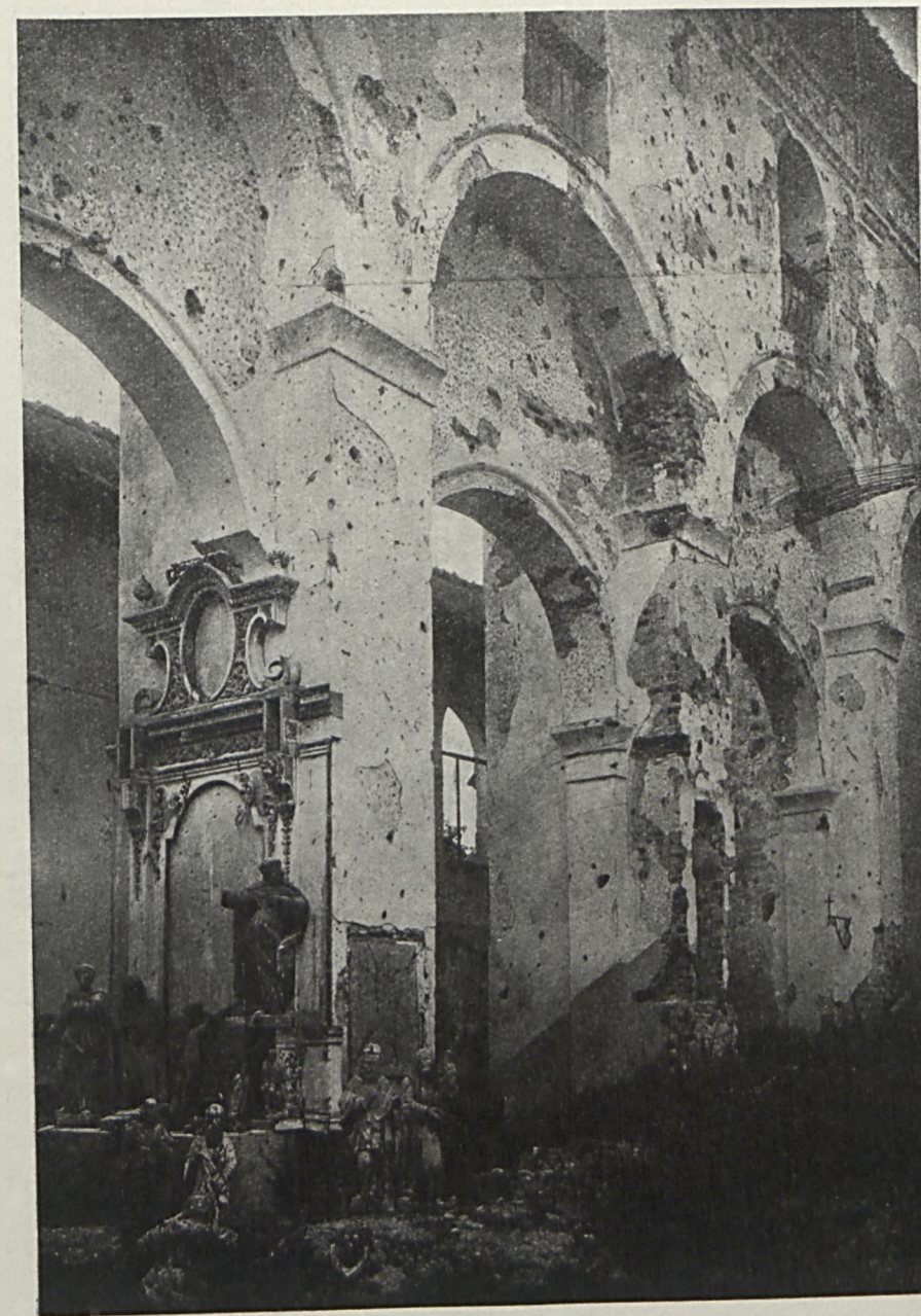
FRAGMENT ZNISZCZONEGO KOŚCIOŁA (BROCHÓW) FRAGMENT DE L'ÉGLISE DÉTÉRIORÉE (BROCHÓW)
