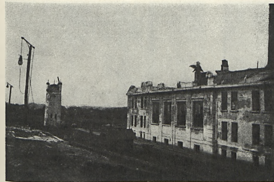
ZNISZCZONA ELEKTROWNIA LWOWSKA USINE D'ÉLECTRICITÉ DE LWÓW DÉTERIORÉE
