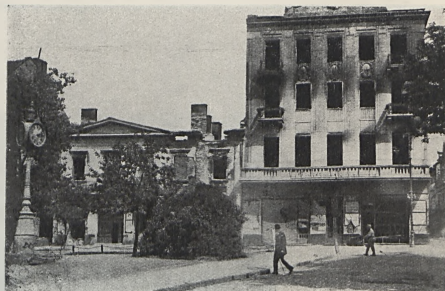
ZNISZCZONE DOMY W TARNOPOLU MAISONS DÉTÉRIORÉES À TARNOPOL
