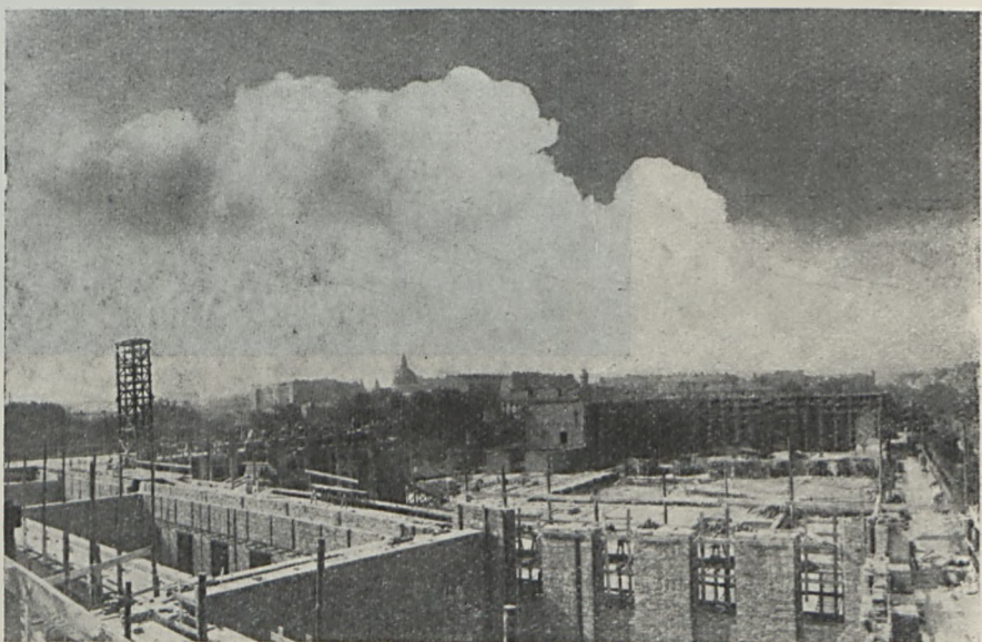
ROBOTY BUDOWLANE W WARSZAWIE BÂTIMENTS EN CONSTRUCTION À VARSOVIE
