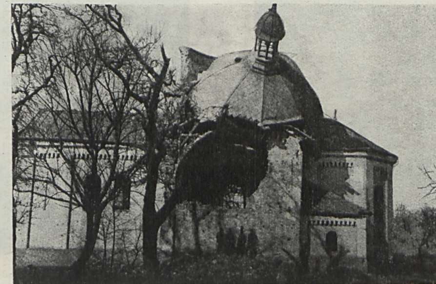
ZBURZONA CERKIEWKA ÉGLISE ORTHODOXE BOMBARDÉE
