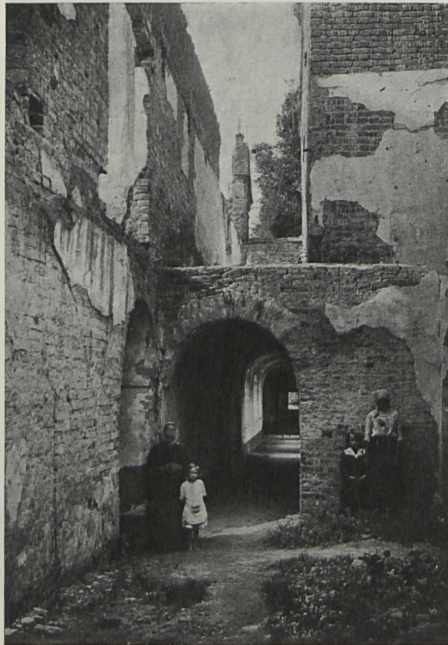
LUTOMIERSK (KOŚCIÓŁ O. O. REFORMATÓW) ÉGLISE DES PÈRES FRANCISCAINS DÉCHAUSSÉS À LUTOMIERSK
