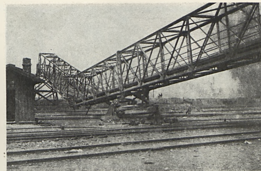
WIADUKT LWOWSKI VIADUC À LWÓW
