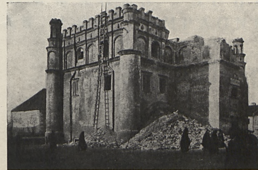
USZKODZONY ZABYTKOWY RATUSZ W SZYDŁOWCU HÔTEL DE VILLE DE SZYDŁOWIEC, CLASSÉ COMME MONUMENT, QUI A SUBI DES DÉGÂTS IMPORTANTS
