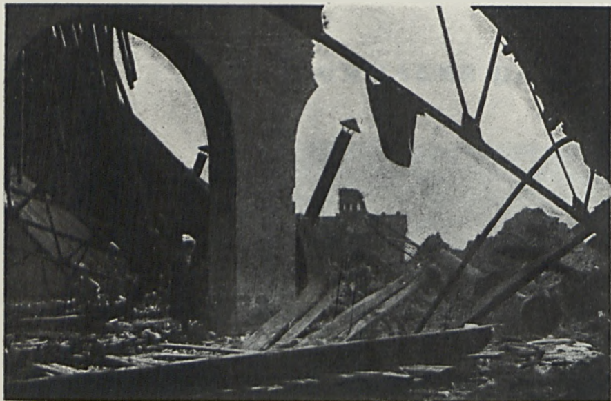
ZBURZONE URZĄDZENIA STACYJNE W ŁODZI (REMIZA) BÂTIMENTS DÉTRUITS DE LA GARE DE ŁÓDŹ (REMISE)
