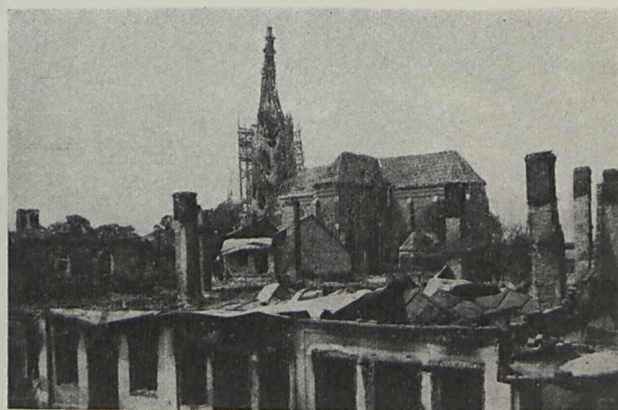
W ZNISZCZONYCH MIASTECZKACH MAŁOPOLSKI WSCHODNIEJ (KAMIONKA STRUMIŁOWA) BOURGS DÉVASTÉS DE LA PETITE POLOGNE ORIENTALE (KAMIONKA STRUMIŁOWA)
