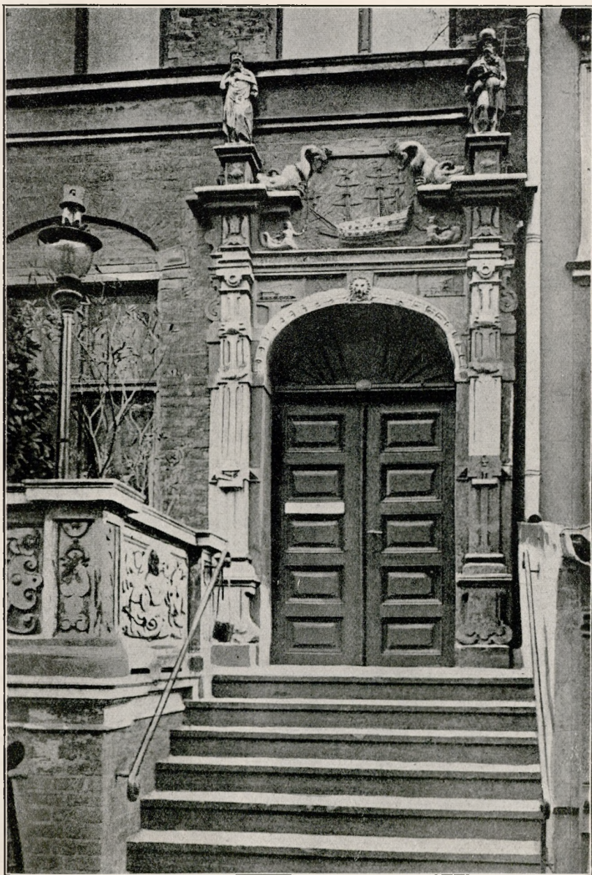
Gdańsk. — Odrzwia dawnego Domu Gildji Okrętowej.
