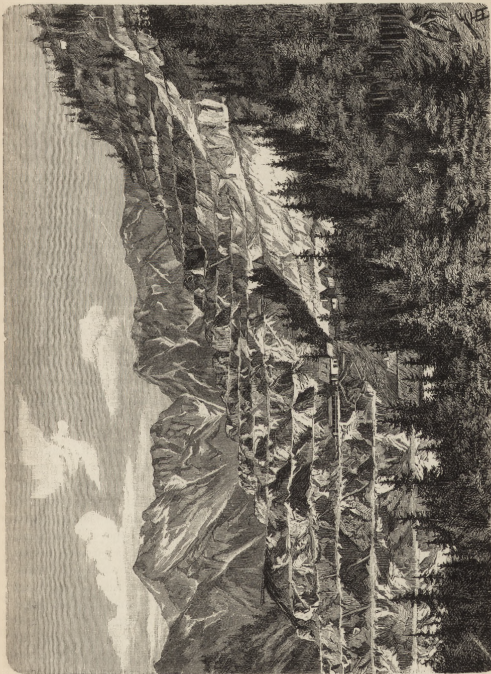
Рис. 684. Ступенчатая разработка Рудной Горы въ Эссенердѣ въ Штиріи. Видимый на переднемъ планѣ горный склонъ состоитъ изъ шпатоватаго желѣзняка, который добывается открытыми разработками въ нѣсколько этажей.
