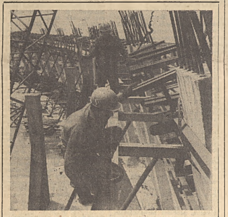
Na budowie elektrowni. W Brzeziu k/Opola trwają prace przy wznoszeniu elektrowni „Opole”. Obecnie m. in. prowadzi się roboty przy budowie unikalnych chłodzi, które będą schładzać ujętą do uzyskania energii wodę. Na zdjęciu: wznoszenie gigantycznych chłodzi. Fot. CAF — Okoński
