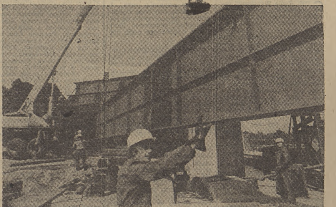
Polscy specjaliści w CSRS. Polscy budowlanci pracują przy budowie 3-przełazowego mostu na Łabie oraz portu załadunkowego w Levošicach. Inwestycje te mają duże znaczenie dla gospodarki czechosłowackiej. Na zdjęciu: brygada Stanisław Piaseczyński i jego załoga z urołowawskiej „Nawigi” montują kolejną przęsł mostu.
