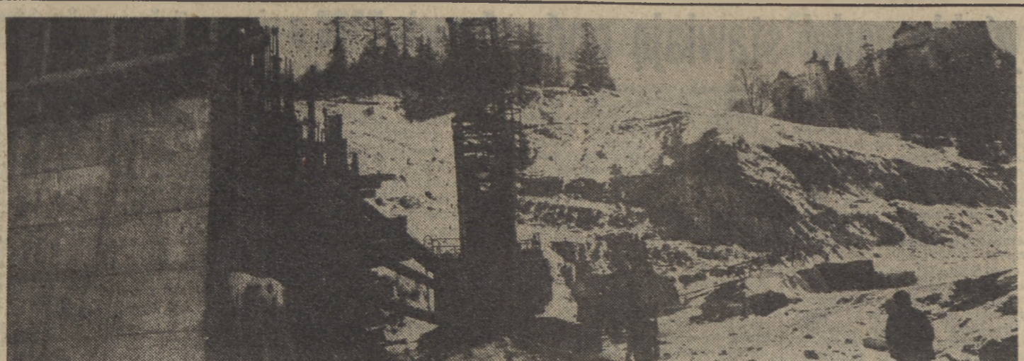
Powstaje zaporę na Dunajcu. Zimowe warunki znacznie utrudniły prowadzenie robót ziemnych i betonarskich. Teraz praca rusza pełną parą. Na zdjęciu: montaż ścian wlotów do sztolni. Fot. CAF — Momot
