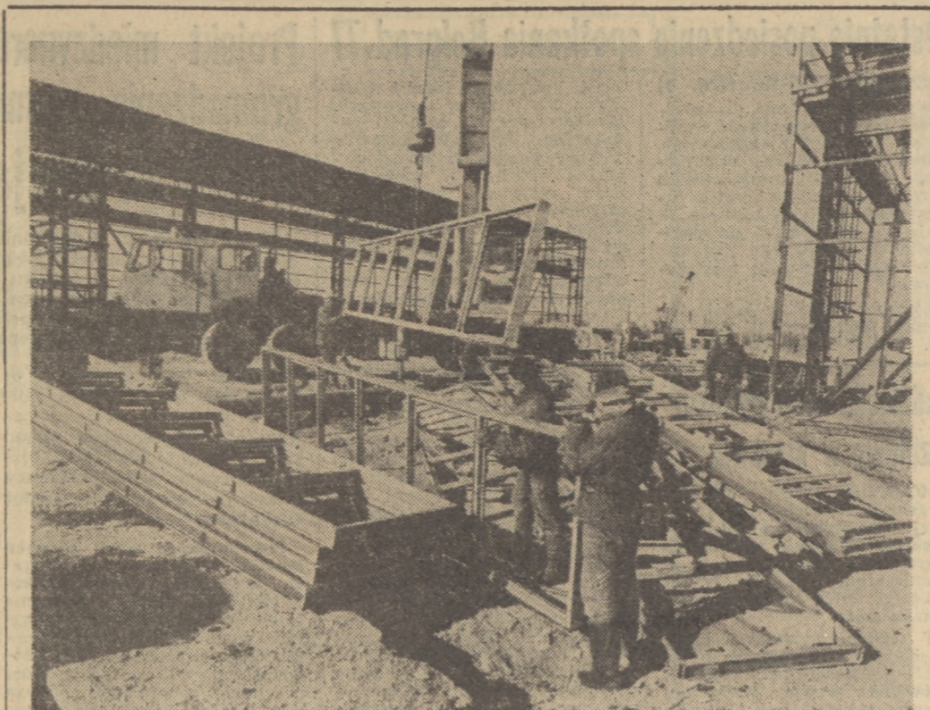
Budowa fabryki domów. W Głogowie (woj. legnickie) powstaje fabryka domów; przeznaczona jest głównie dla potrzeb szybko rozwijającego się zagłębia hutniczego i górniczego. Wytwórnia przygotowywać będzie rocznie 6 tys. izb. Termin zakończenia budowy przewidziany jest na koniec września tego roku. Generalnym wykonawcą inwestycji jest Lubuskie Przedsiębiorstwo Budownictwa Przemysłowego w Nowej Soli. Na zdjęciu: brygada Jana Jagaczewskiego montuje ramy okien.
