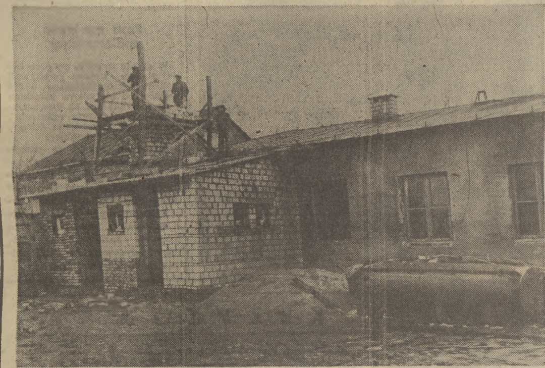
Stara remiza w przebudowie
