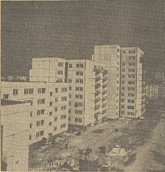
(P) Budowa bloków na terenie osiedla mieszkaniowego w Warszawie „Ursynów-Natolin”. Fot. CAF
