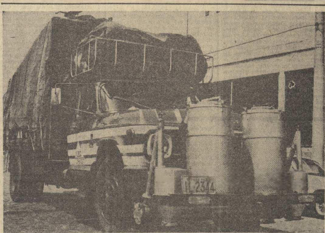
W Brazylii opracowano model silnika samochodowego na gaz otrzymany podczas spalania węgla drzewnego. W silnik ten wyposażony został ciężarówka marki Chevrolet. Przejeżdża on 3 km na 1 kg węgla drzewnego. Paliwo jest bardzo tanie. Rozruch silnika następuje po 5 minutach od rozpalenia „piecyka”; wcześniej można samochodem jechać normalnie na benzynie. Fot. CAF – Camera Press
