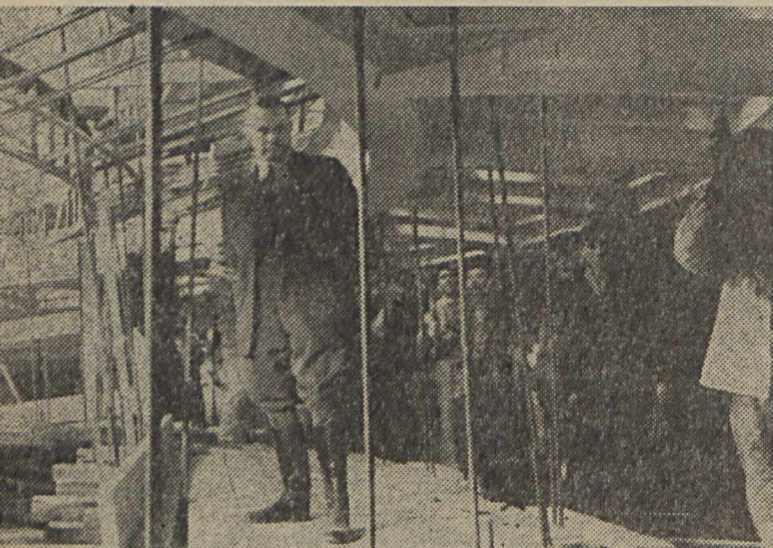
Kopuła kasetonowa konstrukcji prefabrykowanej inż. B. Miszułowicza zmontowana została w ciągu jednej nocy.
