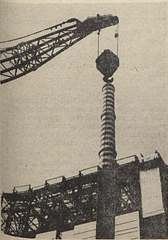
Cała operacja trwała tylko 10 godzin. Na zdjęciu jeden z haków dźwigu i liny oplatające komin.
