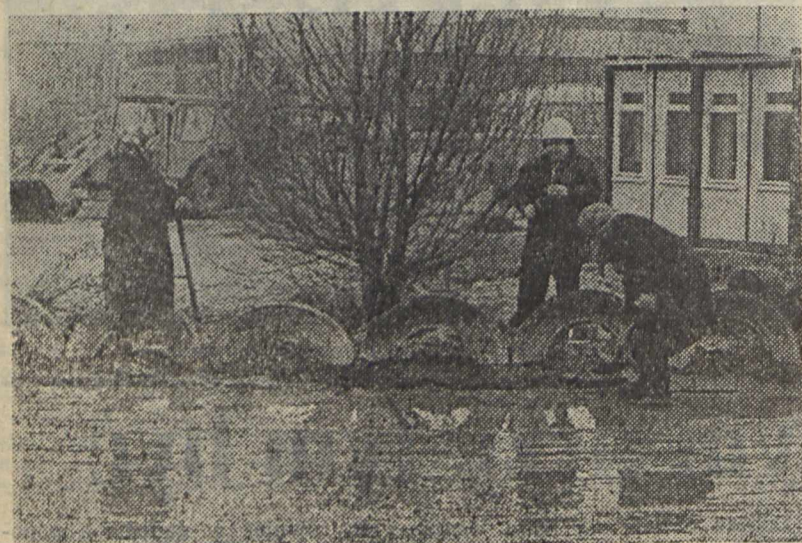
WIOSENNE PORZĄDKI. W połowie kwietnia rozpoczęto porządkowanie terenu przed Beton-Stalem i wokół stołówki.
