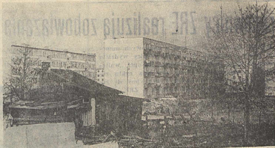
Widok na osiedle Energetyki od strony szpitala szpeci stara, rozpadająca się rudera. Właściciel (kto nim jest?) powinien jak najszybciej rozebrać to zawalisko?
