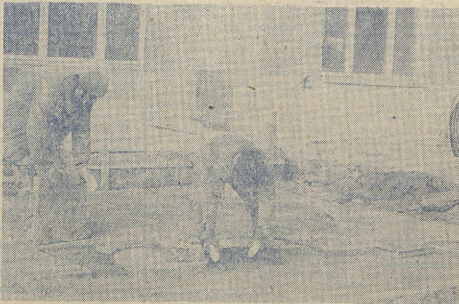
Na budowie internatu trwają prace porządkowe.
