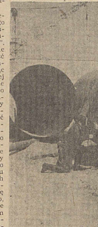
Spawanie rurociągów wody chłodzącej
