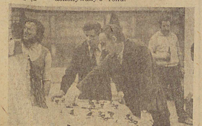
Mistrz dyżurny elektryków Czesław Zawadzka synchronizuje blok nr 6 — godz. 19.16.
