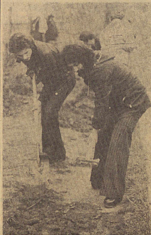
Na zdjęciu: ZMS-owcy z Elektrowni przy kopaniu kanału.
