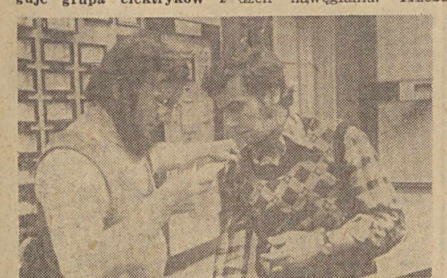
St. mistrz zabezpieczeń elektrycznych Tomasz Koza i specjalista d/s zabezpieczeń inż. Kazimierz Kras analizują wyniki pomiarów oscylograficznych wzbudnicy.
