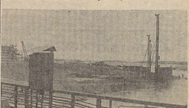
III etap budowy
