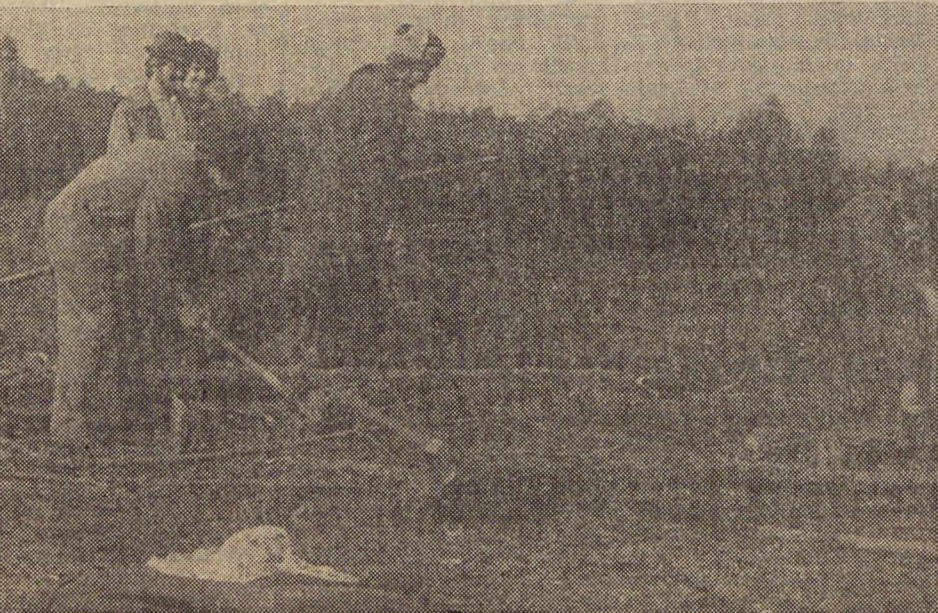
Przy wycince lasu pod rozdzielnią 400 kV
