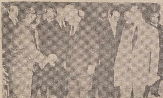
Goście zwiedzają część kotłownią Elektrowni
