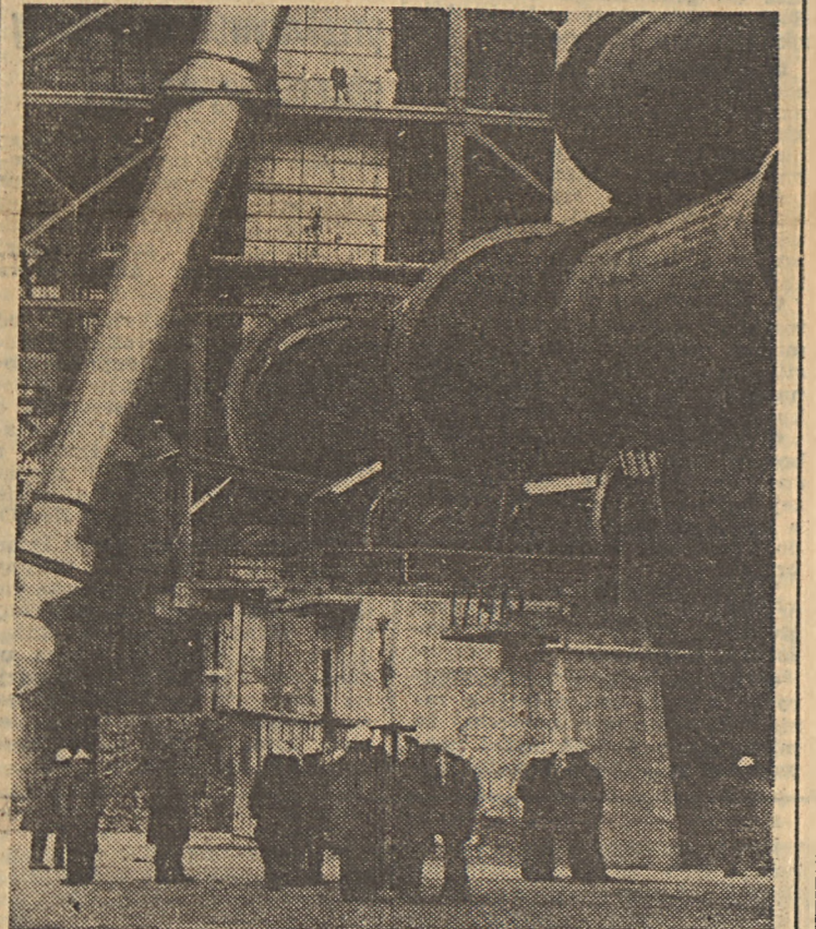
W cementowni „Ożarów”, woj. tarnobrzeskie ruszyła w ub. m. pierwsza nitka klinkieru. W ten sposób zakład, który docelowo wytwarzać będzie 2,4 mln ton cementu, rozpoczął produkcję.
